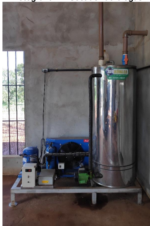
Fotografia 4 – Secador de biogás
