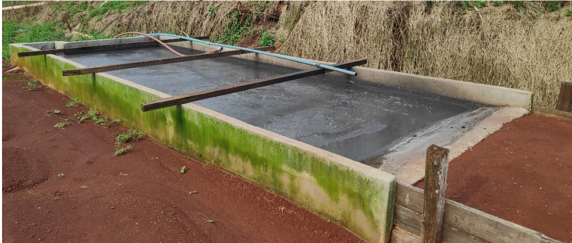
Fotografia 3 – Decantador de sólidos
