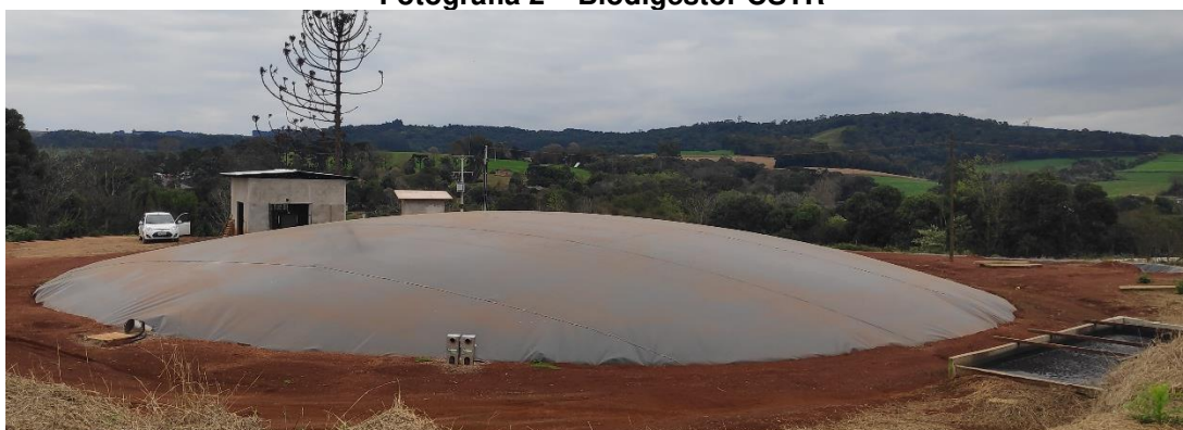
Fotografia 2 – Biodigestor CSTR
