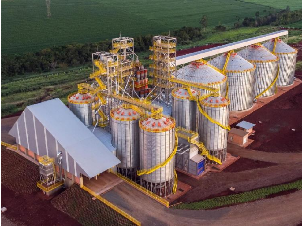
Figura 7 – Unidade de Recebimento
