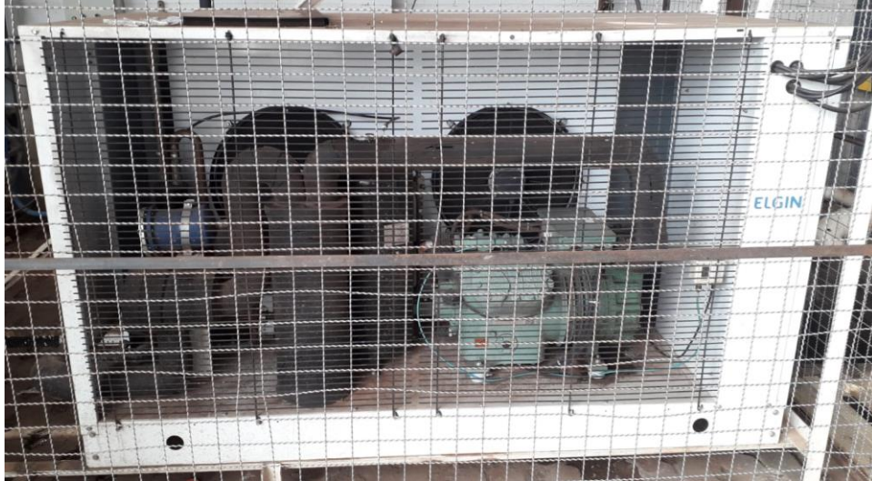
Figura 21 - Unidade Condensadora Elgin BBT2300L6C-021B
