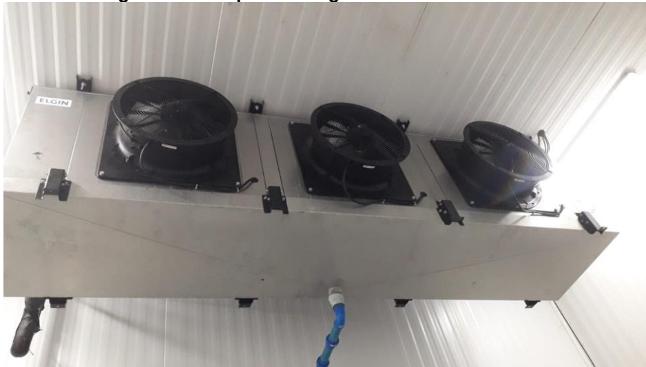
Figura 20 – Evaporador Elgin EPH503DLCSAHSS0A
