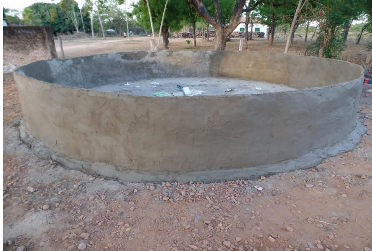
Figura 11 - Reservatório em estrutura ferro cimento
