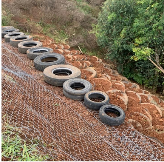
Fotografia 4 - Amarrações dos pneus com arame zincado de 1,65mm
