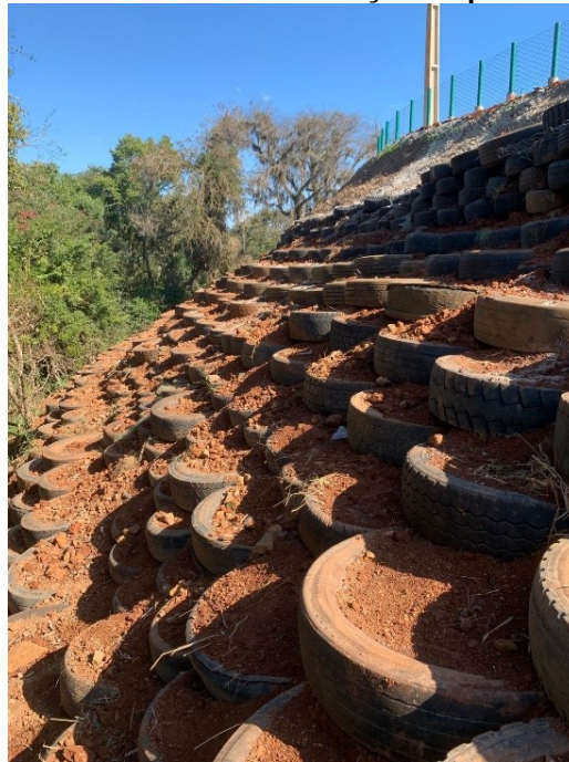
Fotografia 5 - Estrutura de contenção de pneus finalizada
