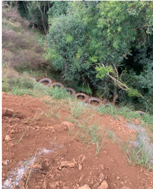
Fotografia 3 - Início da execução da contenção de pneus
