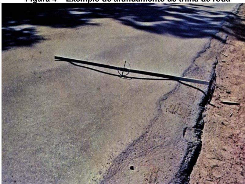
Figura 4 – Exemplo de afundamento de trilha de roda
