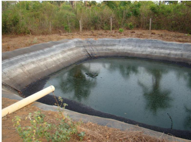
Fotografia 4 – Exemplo de reservatório de digestato
