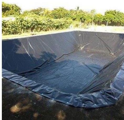
Fotografia 2 - Exemplo de escavação de fossa e aplicação de lona de impermeabilização
