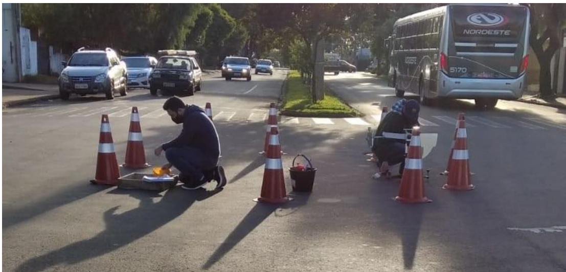
Figura 25 – Local de ensaio no ponto crítico 8
