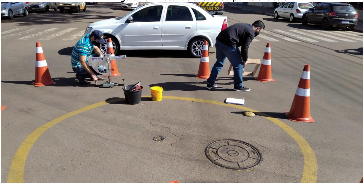
Figura 18 – Local de ensaio do ponto crítico 5
