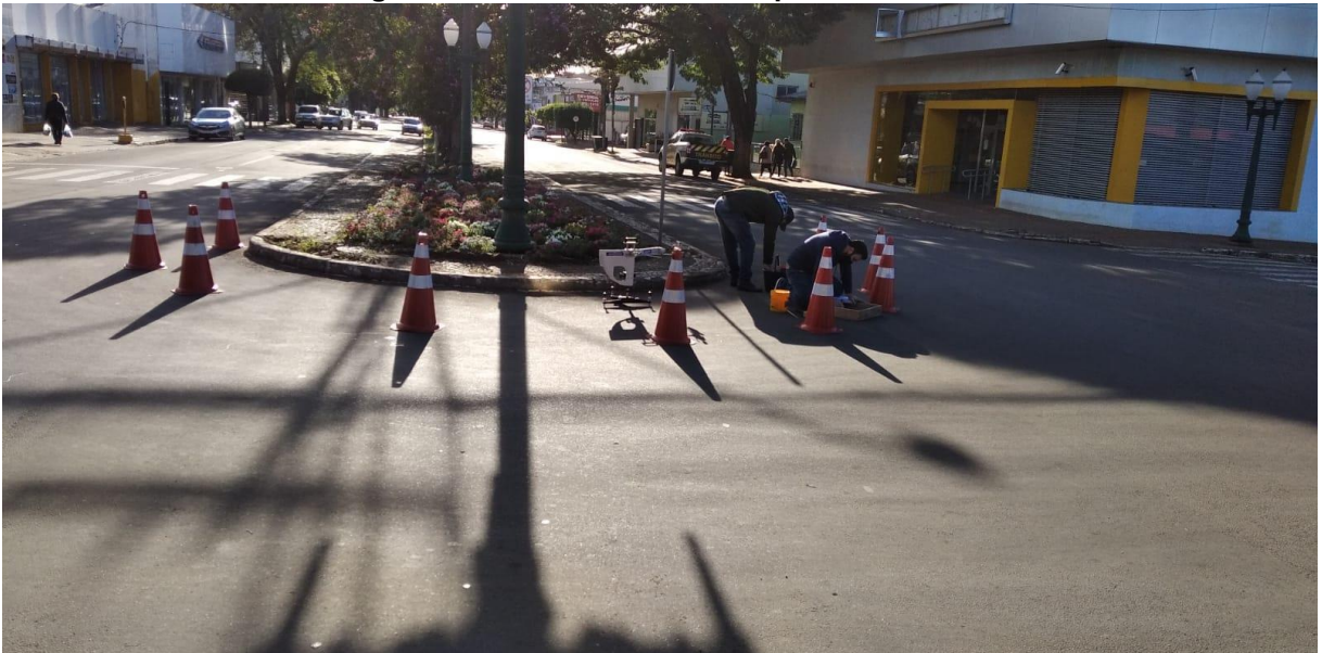
Figura 27 – Local de ensaio no ponto crítico 9
