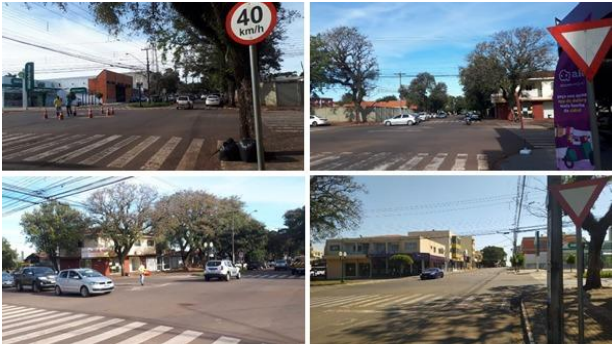
Figura 22 – Cruzamento da Avenida Irmãos Pereira com a Rua Roberto Brzezinski
