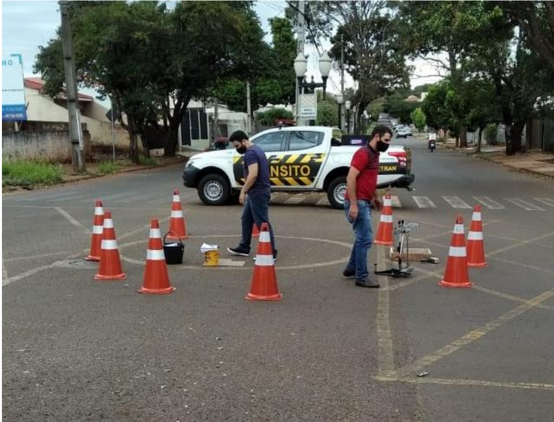
Figura 13 – Local de ensaio no ponto crítico 3
