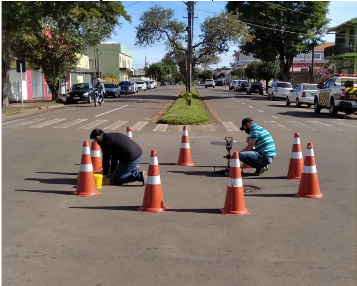
Figura 21 – Local de ensaio no ponto crítico 6
