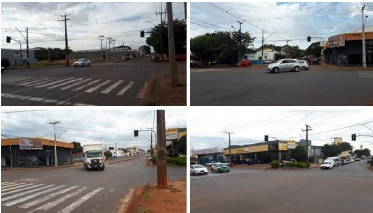
Figura 7 – Cruzamento da Perimetral Tancredo Neves com a Rua Araruna
