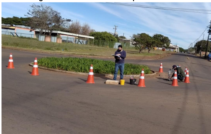
Figura 31 – Local de ensaio no ponto crítico 11
