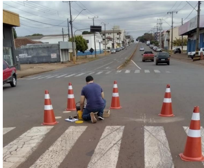
Figura 9 – Local de ensaio no ponto crítico 1
