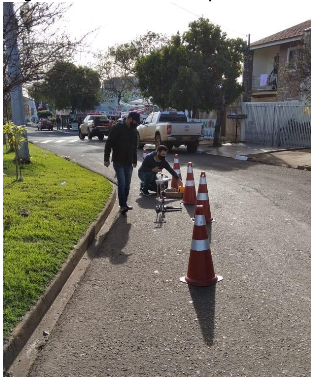
Figura 29 – Local de ensaio no ponto crítico 10
