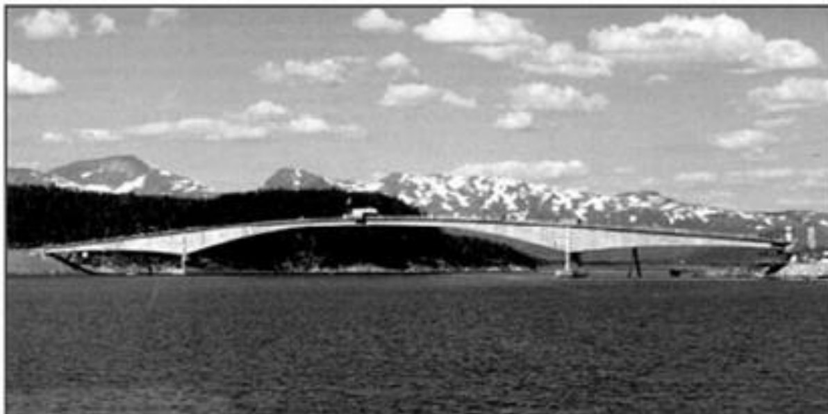
Figura 17 - Ponte Stovset, na Noruega.
