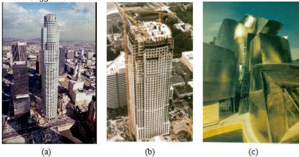
Figura 23 - Edifícios construídos com concreto leve: a) Library Tower, b) Edifício Nationsbank, e c) Museu Guggenheim-Bilbao.
