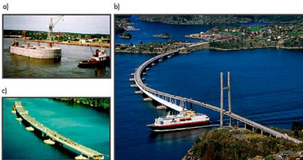
Figura 19 - Ponte flutuante Nordhordland, na Noruega: a) Transporte de um “caixão” flutuante, b) trecho do tabuleiro apoiado nos “caixões”; c) Ponte concluída.
