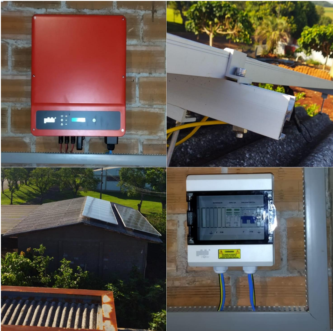
Figura 42 - Registros fotográficos da instalação do gerador FV
