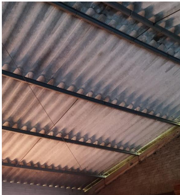
Figura 35 - Estrutura de sustentação do telhado nordeste do galpão
