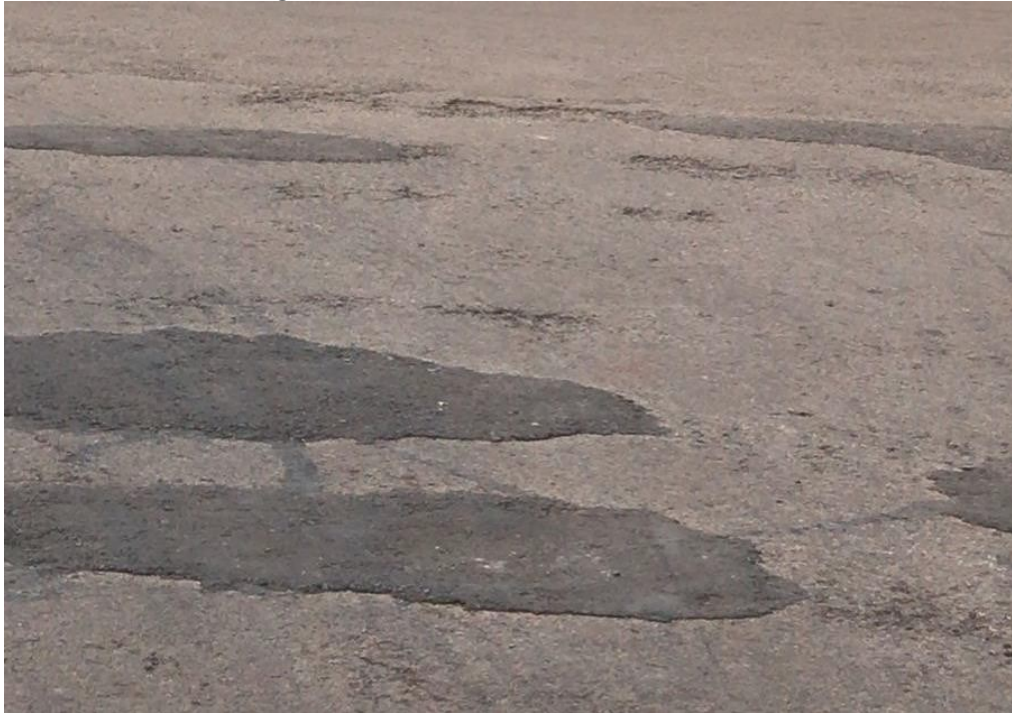
Figura 15 – Remendos nas vias avaliadas
