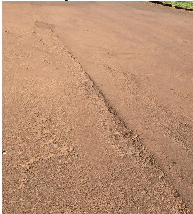
Figura 6 - Afundamento
