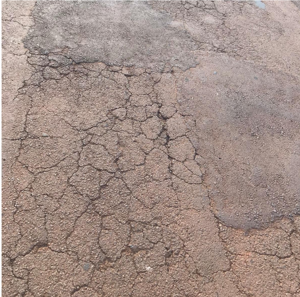
Figura 17 - Combinação de defeitos nas vias avaliadas
