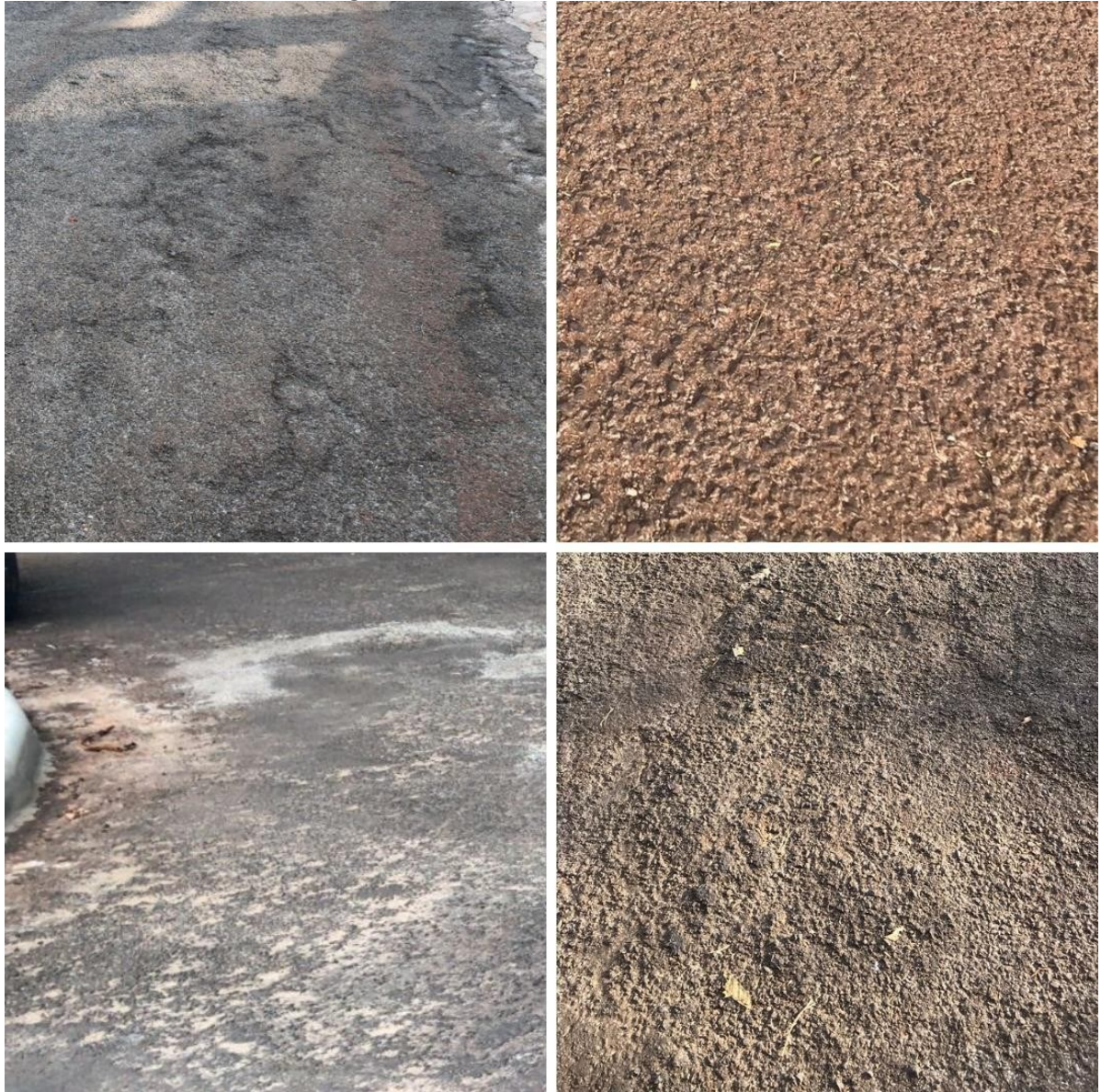
Figura 14 - Desgaste nas vias avaliadas
