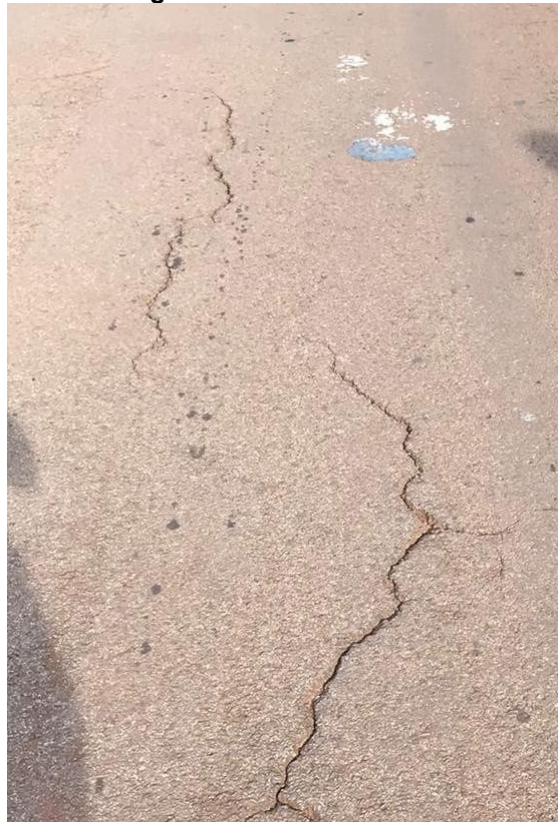
Figura 3 - Trincas Isoladas
