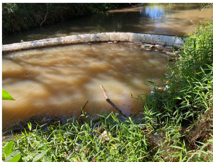
Figura 22 - Ecobarreira instalada próxima ao ponto 3
