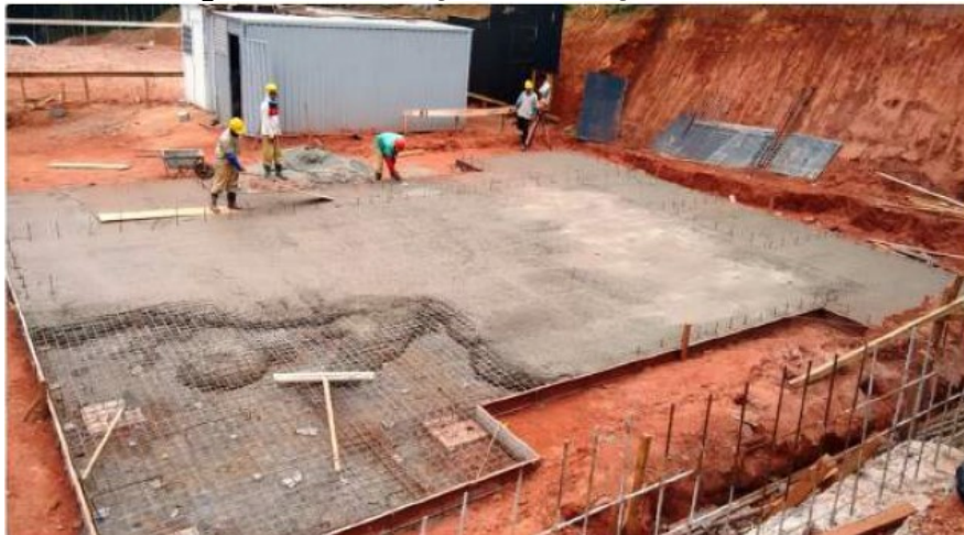
Figura 11: Construção de fundação em radier
