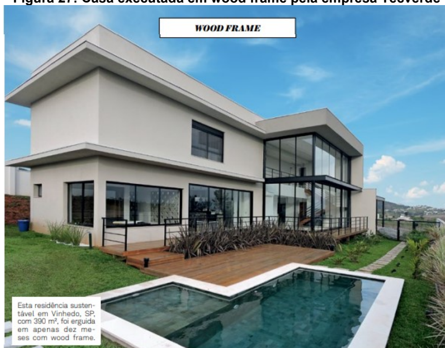
Figura 27: Casa executada em wood frame pela empresa Tecverde
