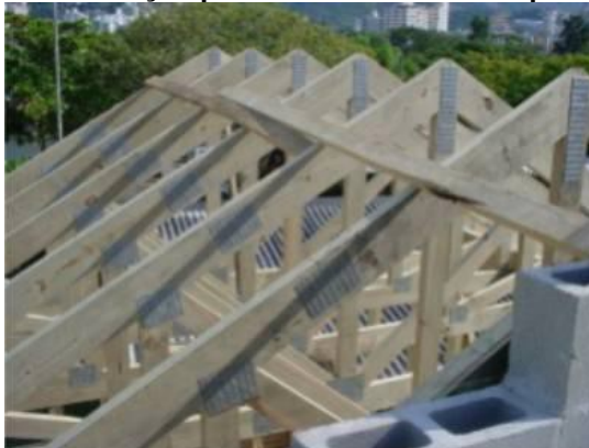
Figura 21: Treliças pré-fabricadas com chapas-prego
