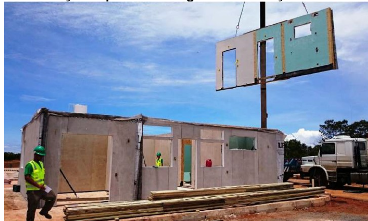
Figura 20: Painéis içados para a montagem da edificação no canteiro de obras
