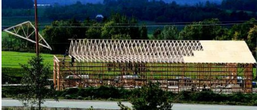
Figura 22: Treliças pré-fabricadas de grande porte utilizando equipamentos para montagem
