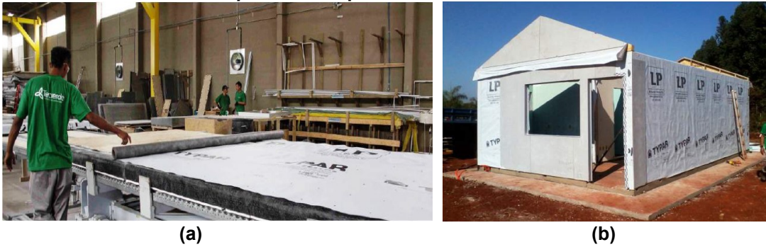
Figura 16: Membrana hidrófuga: (a) sendo colocada sobre painel; (b) painel montado com parte de chapeamento cimentício
