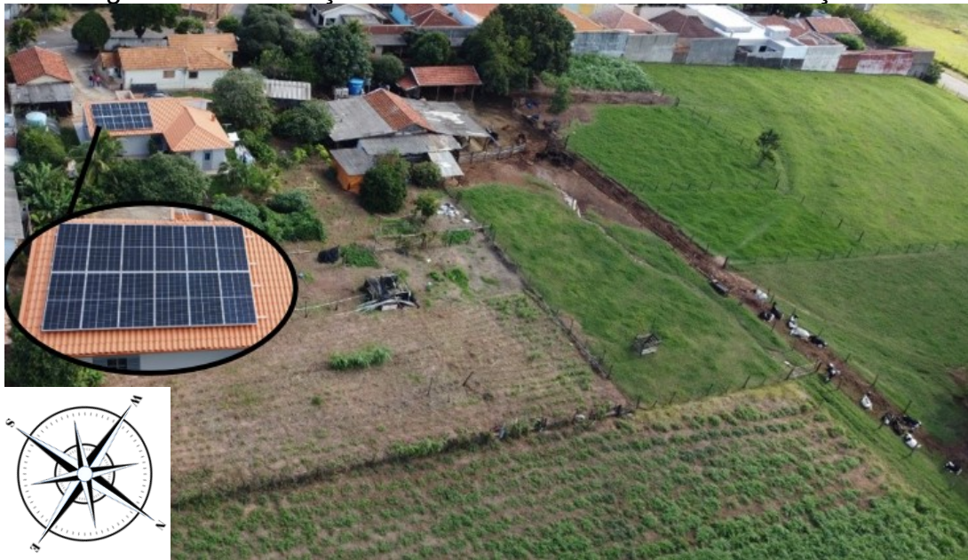
Fotografia 1- Localização dos módulos fotovoltaicos – edificação rural
