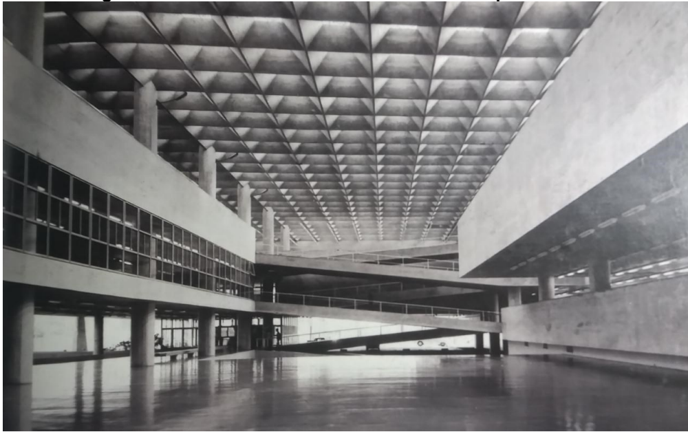
Figura 27 - Vista interna do Salão Caramelo do prédio da FAU
