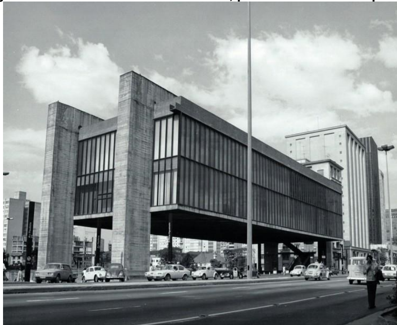
Figura 3 - Museu de Arte de São Paulo, pilares de concreto aparente
