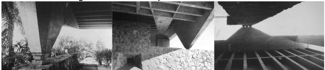
Figura 8 - Detalhe dos apoios articulados.
