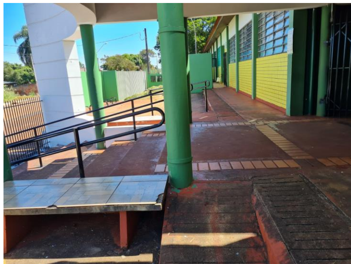
Fotografia 8 – Rampa com Obstáculo de Pilar
