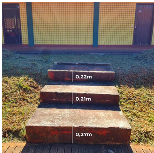
Fotografia 18 - Escada para Acesso ao Bloco 3
