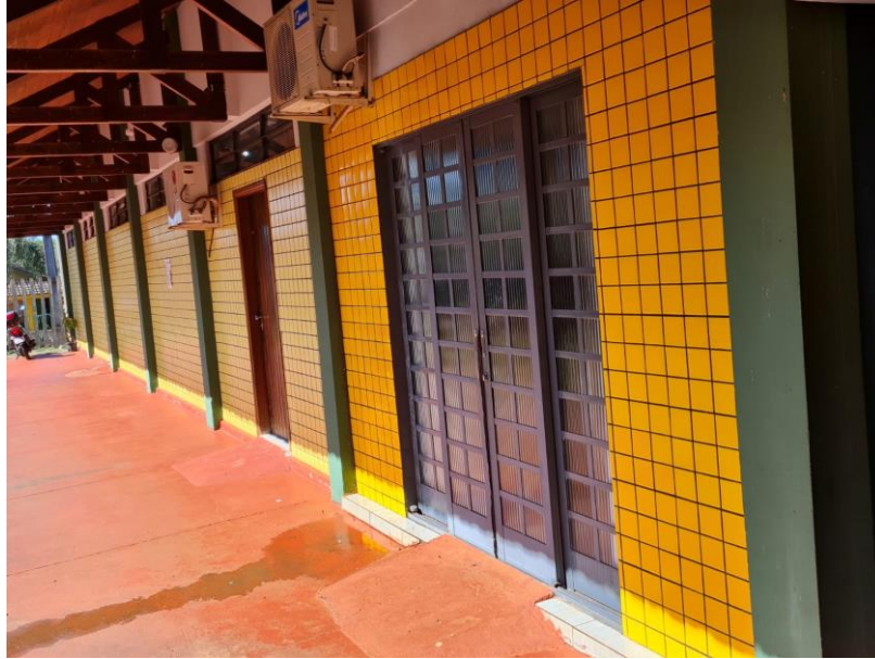
Fotografia 21 – Acesso ao Refeitório
