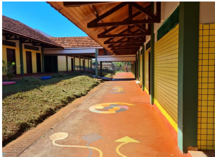
Fotografia 20 - Circulação para Acesso aos Cômodos
