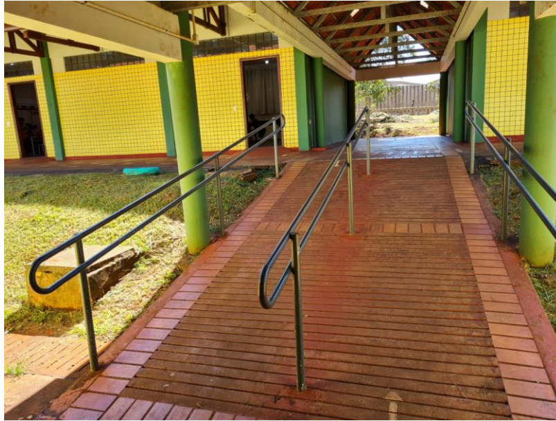
Fotografia 19 – Rampa de Acesso aos Blocos
