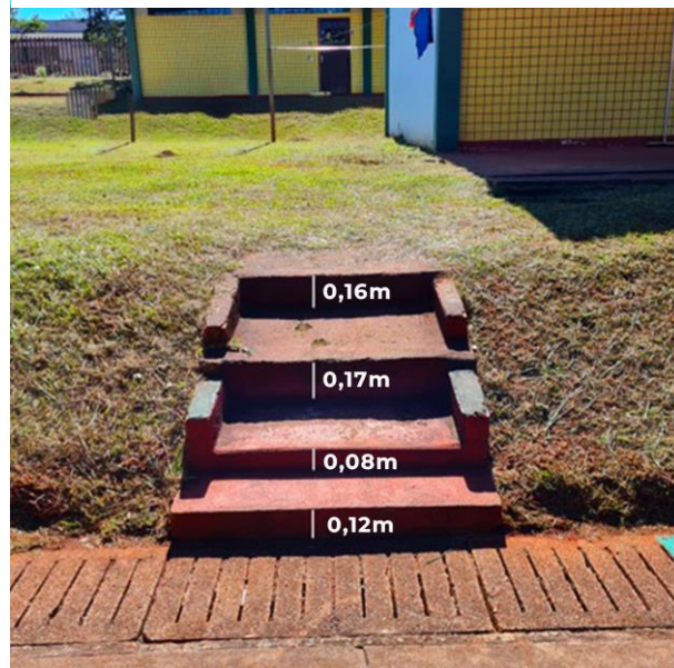
Fotografia 17 – Escada para Acesso ao Bloco 3
