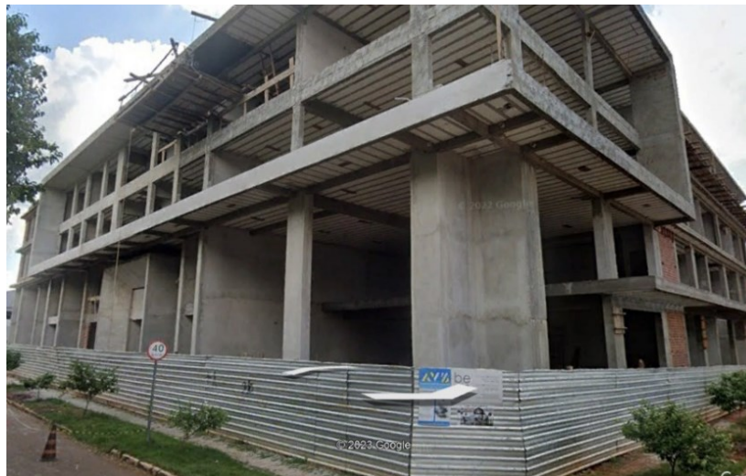
Figura 19 – Vista lateral do edifício em estudo
