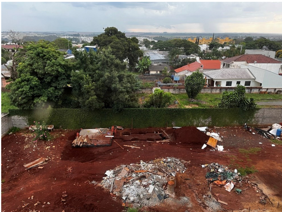
Figura 18 – Vista aérea dos resíduos sólidos gerados na fase de construção do edifício
