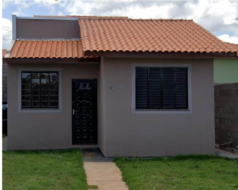
Fotografia 1 – Fachada frontal da edificação
