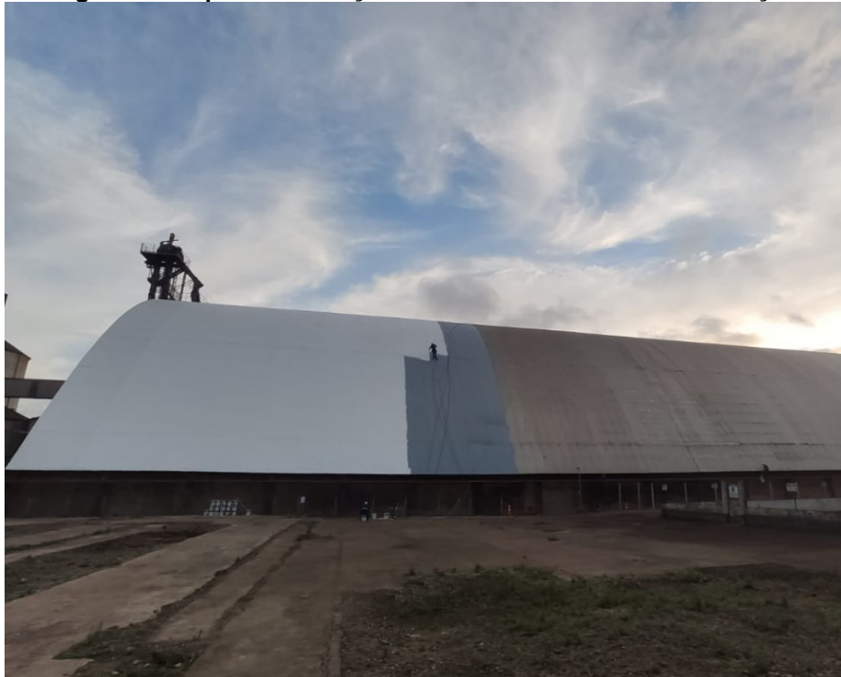
Figura 10: Impermeabilização da cobertura em fase de execução
