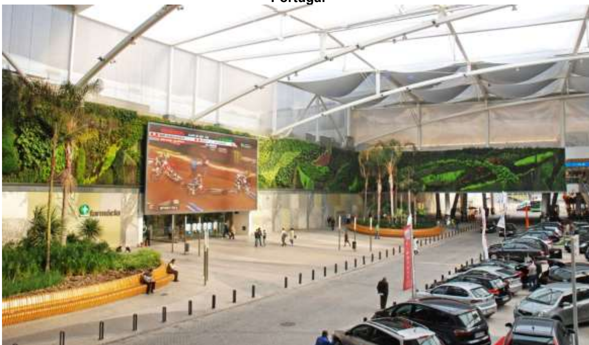
Figura 14- Execução da parede viva contínua com painel geotêxtil em Lisboa, Portugal
