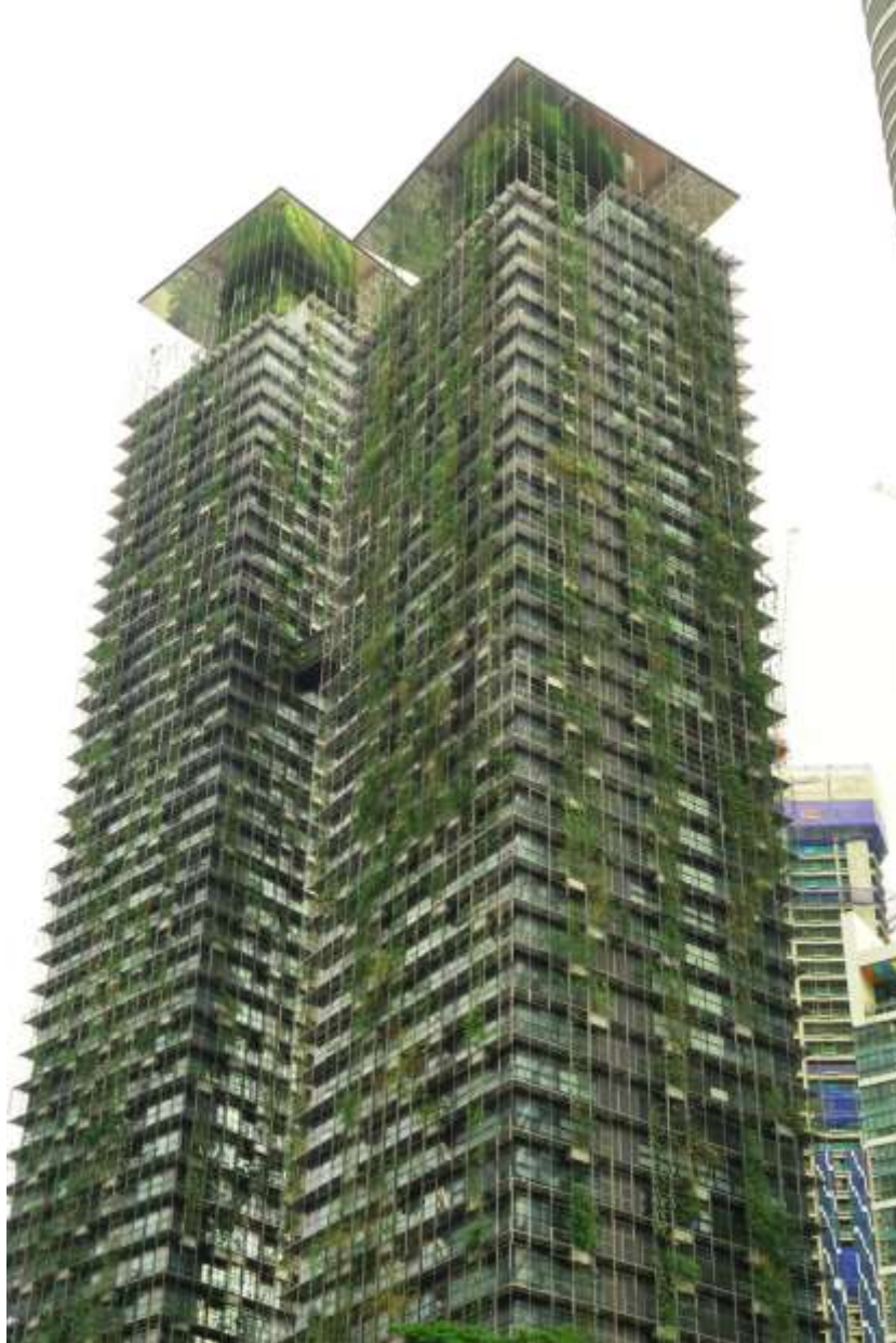
Figura 8 - Sistema modular no edifício Le Nouvel, Kuala Lumpu -Malásia
