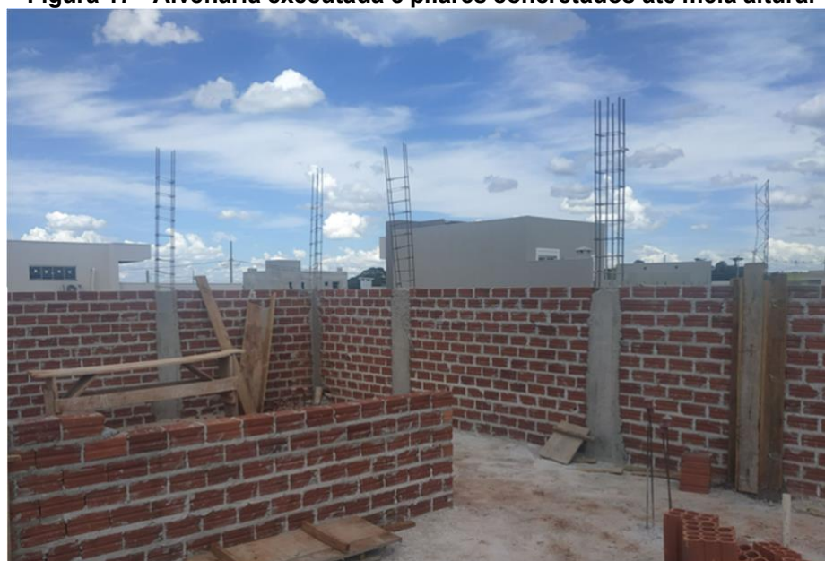
Figura 17 - Alvenaria executada e pilares concretados até meia altura.
