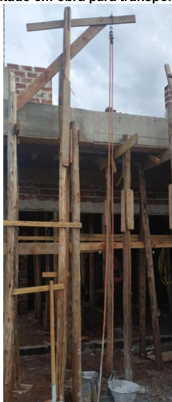
Figura 11 – Sistema montado em obra para transporte vertical de argamassa.
