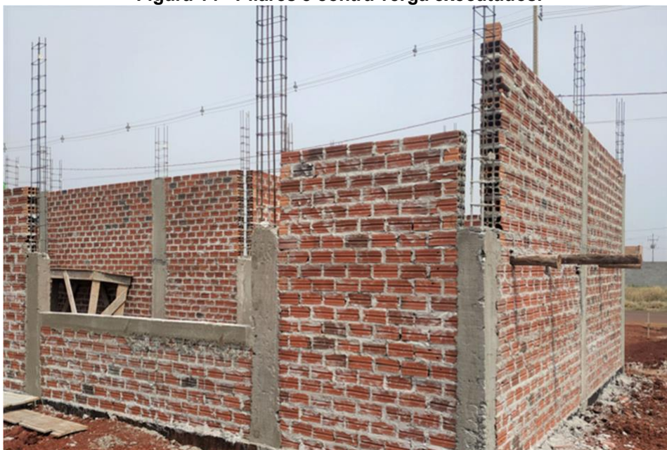
Figura 14 - Pilares e contra verga executados.
