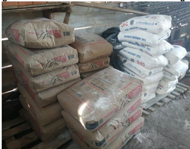
Figura 12 – Armazenamento de cimento e cal virgem.
