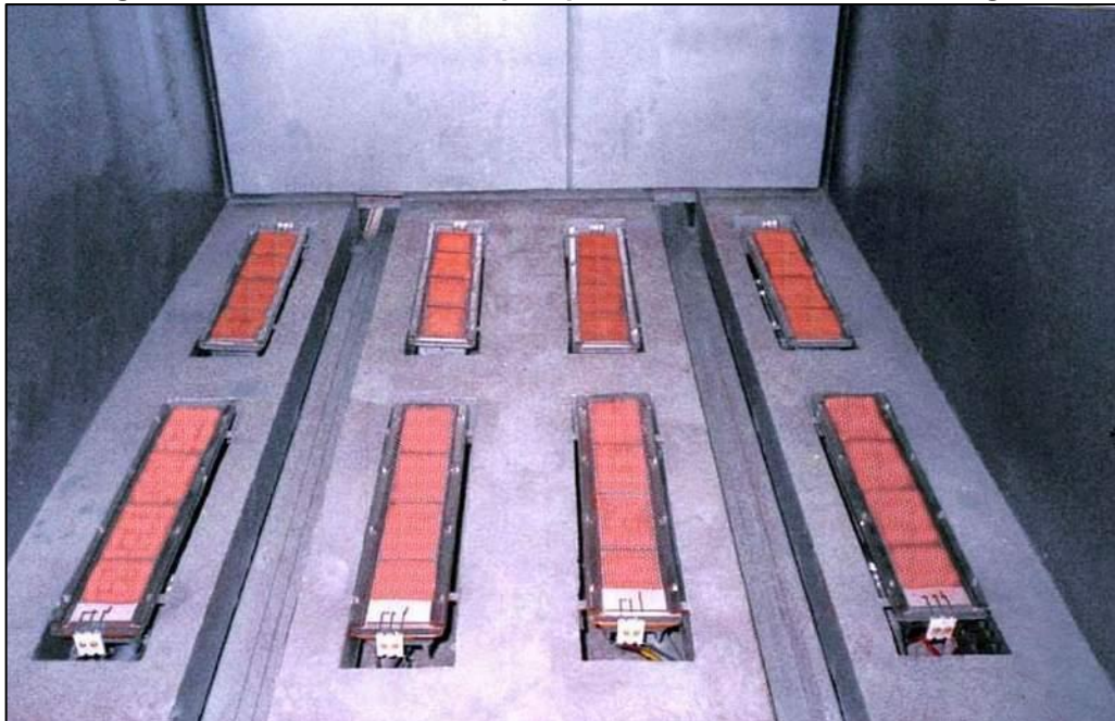
Figura 12 – Forno alimentado por queimadores infravermelhos à gás
