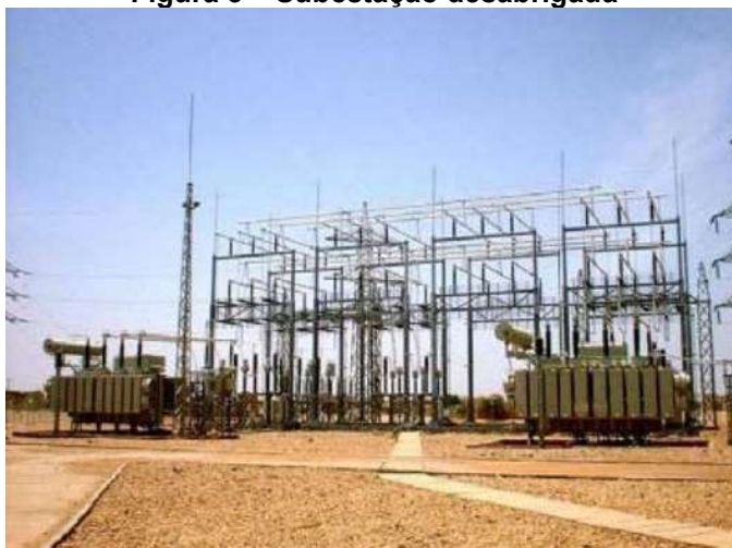
Figura 3 – Subestação desabrigada
