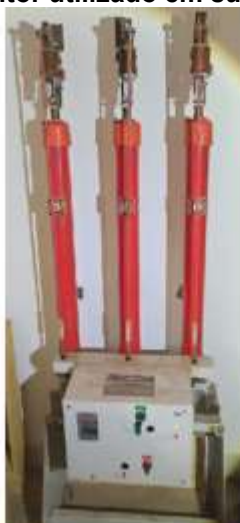
Figura 6 – Disjuntor utilizado em subestações
