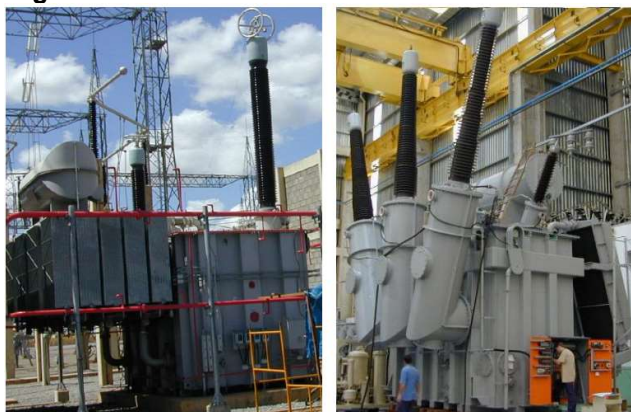
Figura 10 – Transformador monofásico e trifásico
