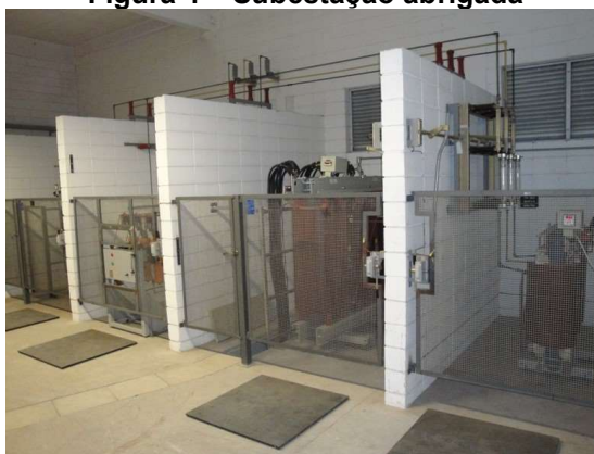
Figura 4 – Subestação abrigada
