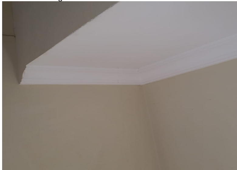
Figura 26 – Molde de Gesso Instalado
