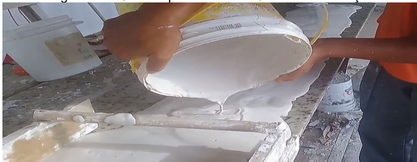
Figura 22 – Carrilho para Molde de Gesso em Execução
