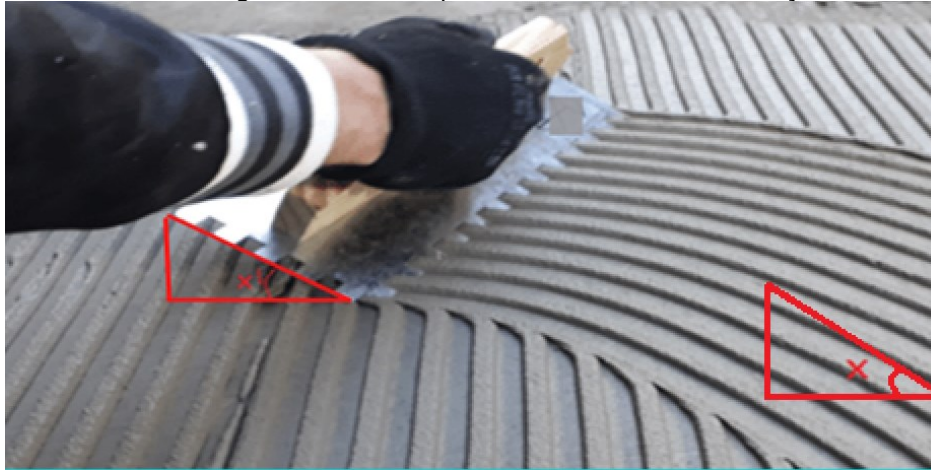
Figura 20 – Desempenadeira dentada em execução
