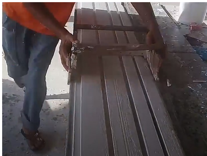
Figura 23 – Carrilho para Molde de Gesso em Execução 2
