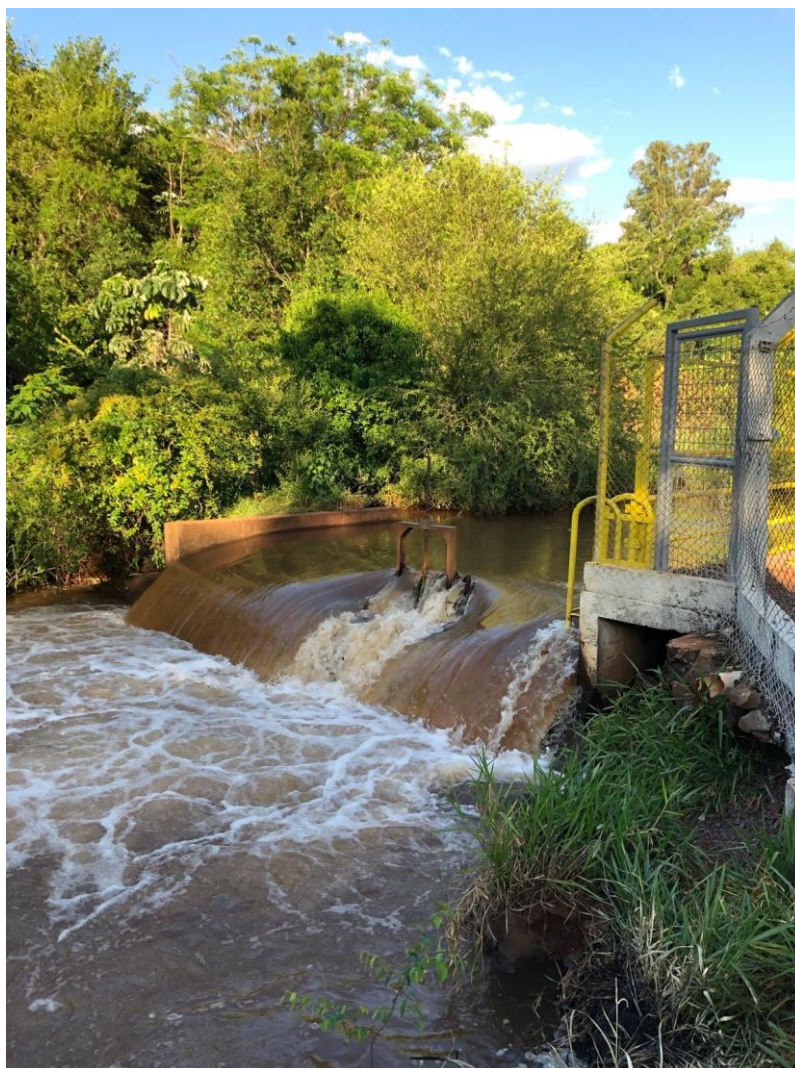
Figura 11 - Ponto de captação superficial do Rio Toledo.
