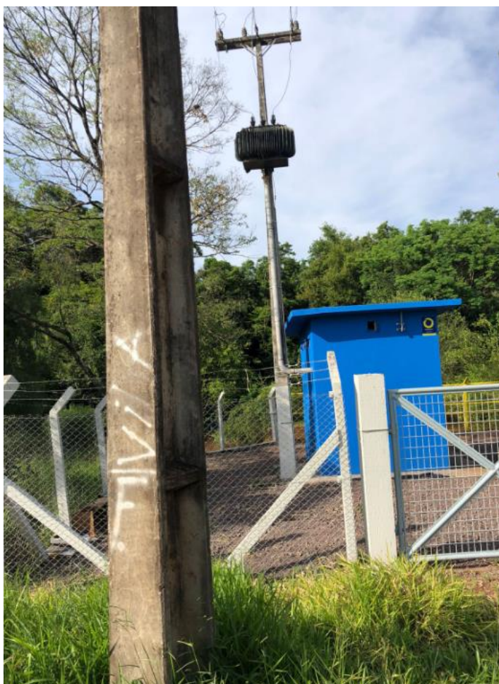
Figura 16 - Vestígios de vandalismo no entorno da área de captação superficial.
