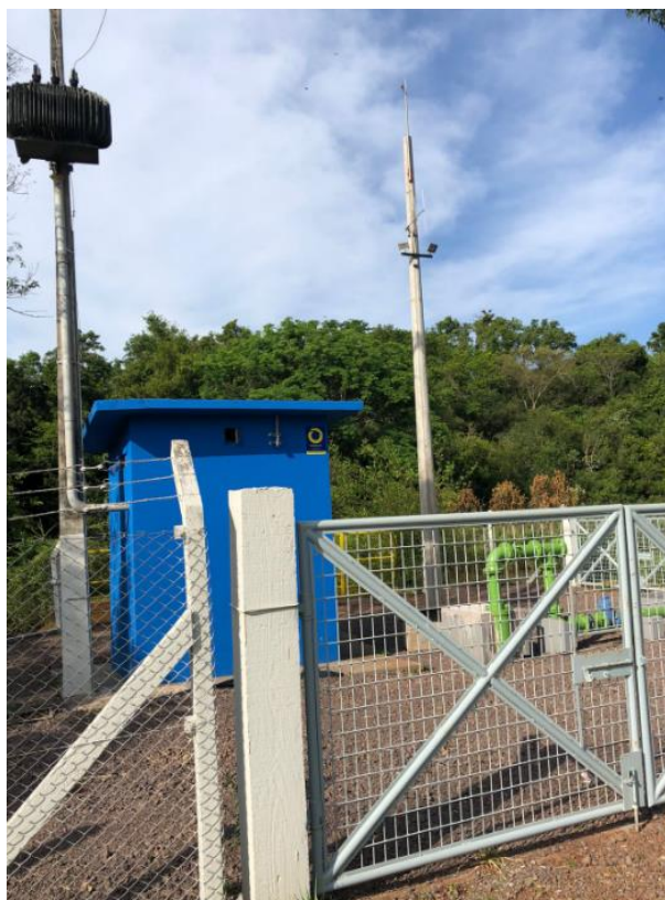
Figura 14 - Cercamento do acesso ao ponto de adução de água da captação superficial
