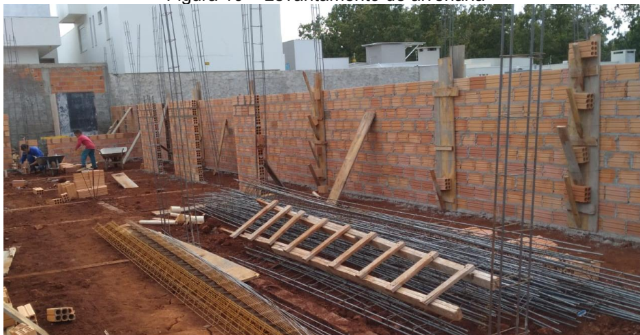
Figura 16 – Levantamento de alvenaria
