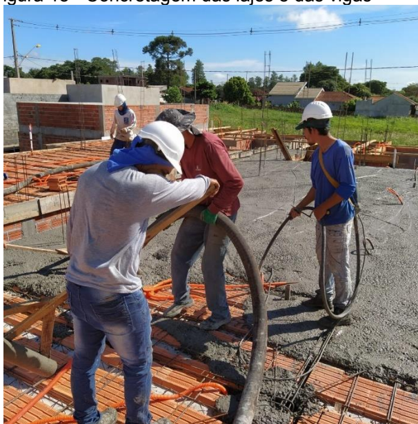
Figura 18 - Concretagem das lajes e das vigas
