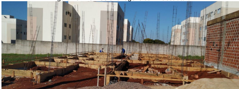
Figura 10 - Formas e ferragens da infraestrutura
