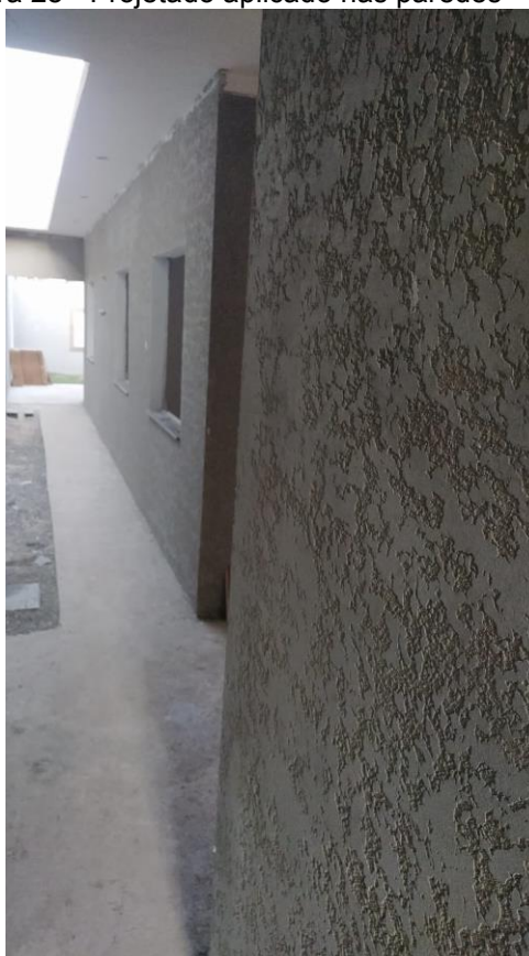
Figura 28 - Projetado aplicado nas paredes
