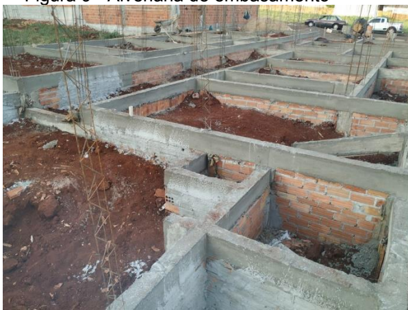
Figura 9 - Alvenaria de embasamento
