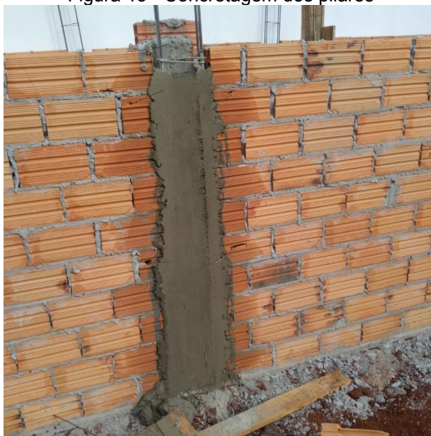
Figura 15 - Concretagem dos pilares
