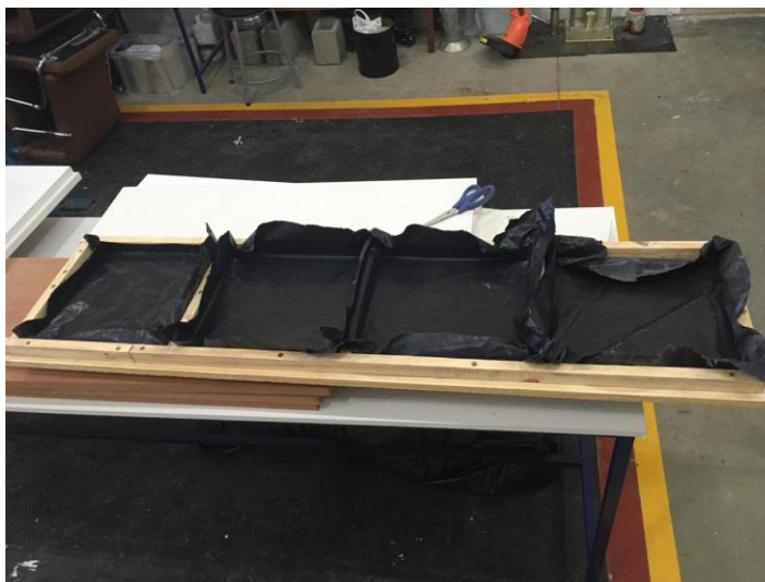
Figura 11 – Colocação das lonas nos moldes
