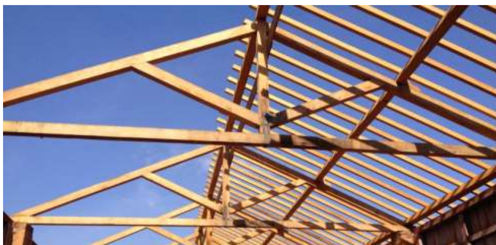
Figura 1: Tesoura de madeira Fonte: Guia da Engenharia, 2019.
