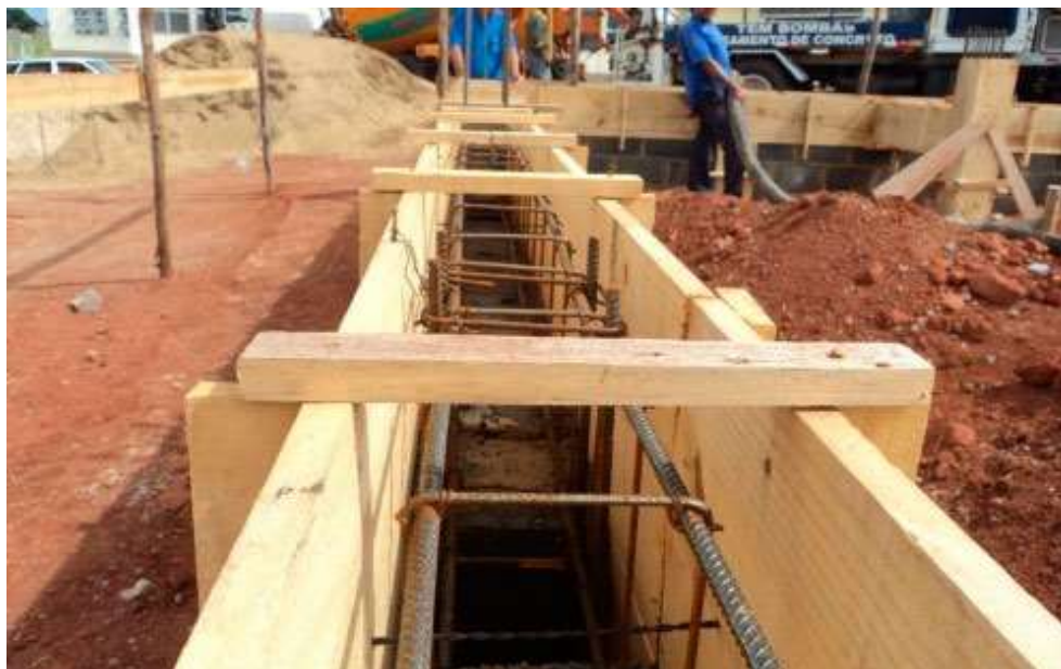
Figura 2: Fôrma de madeira Fonte: Tora Tora Madeiras, 2019.
