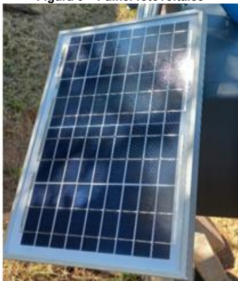
Figura 6 – Painel fotovoltaico
