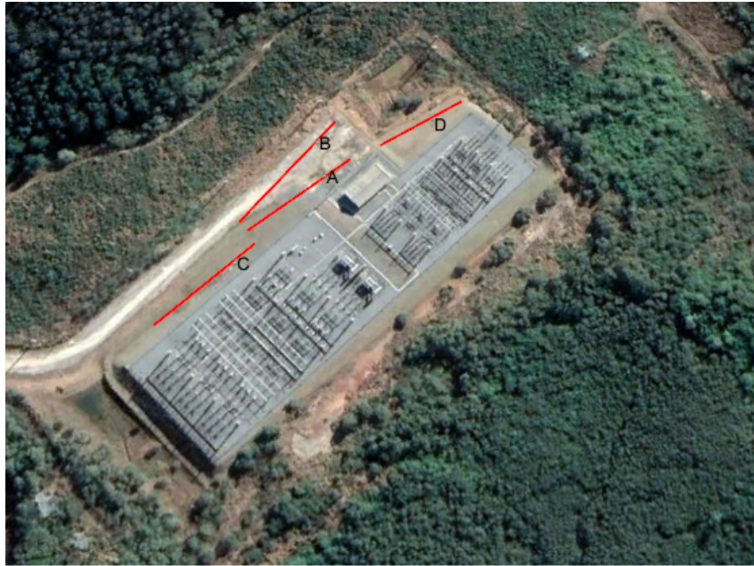
Figura 38 – Vista aérea das medições feitas na SE A1 230 kV em 30/09/2021
