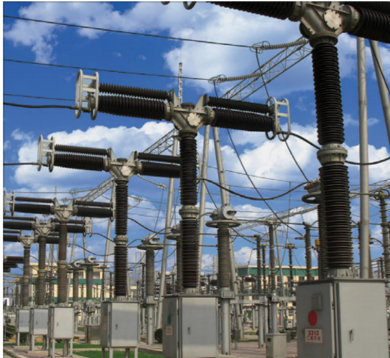
Figura 3- Exemplo de disjuntores.
