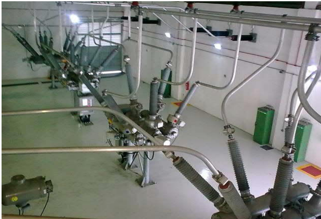
Figura 12 - Exemplo de subestação híbrida.
