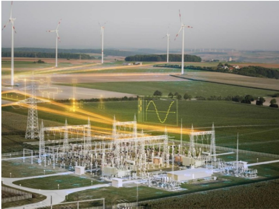
Figura 9 - Exemplo de subestação isolada a ar (AIS).
