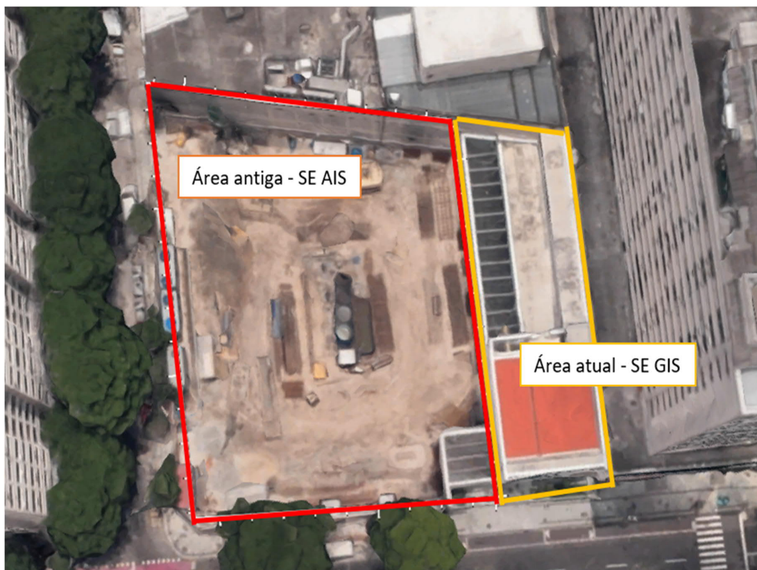
Figura 14 – Área ocupada pela SE Copacabana antes e depois da compactação.
