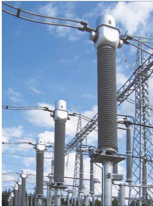
Figura 5- Exemplo de transformador de corrente.
