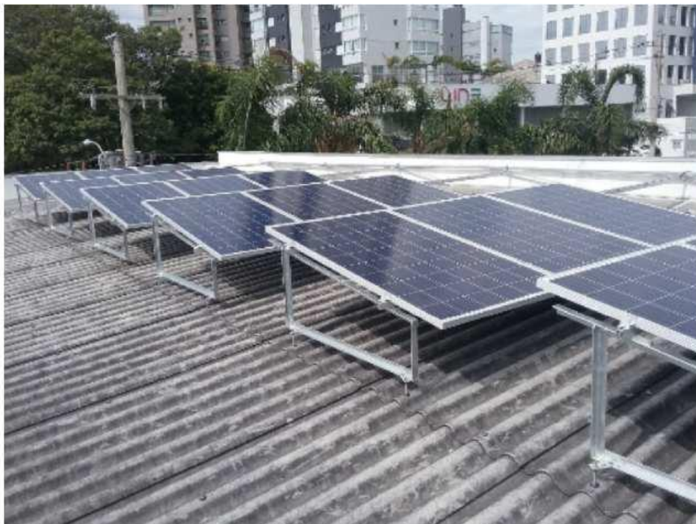
Figura 13: Estrutura de cobertura.
