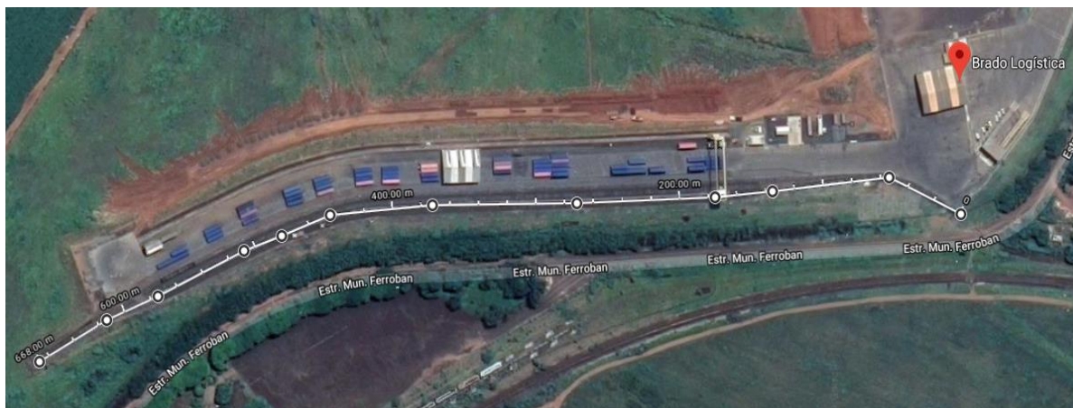
Figura 2.1 - Vista superior do Terminal Brado em Araraquara – SP.
