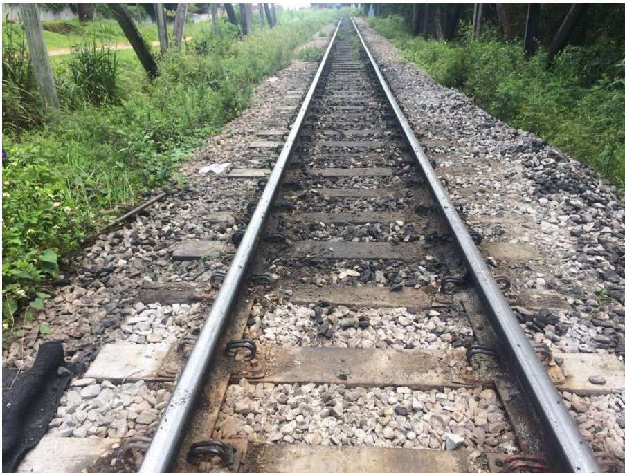
Figura 4 - Trecho com dormentes de madeira de lei
