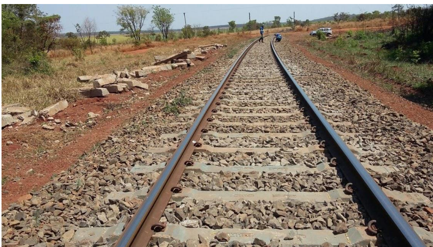
Figura 3 - Trecho com dormentes de concreto monobloco
