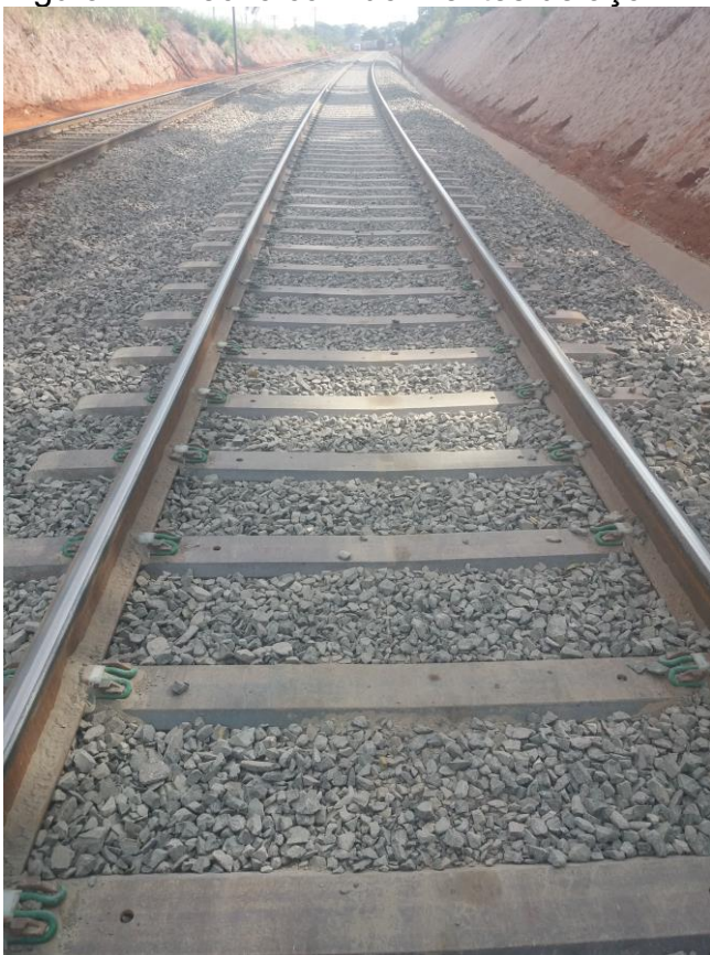
Figura 2 - Trecho com dormentes de aço
