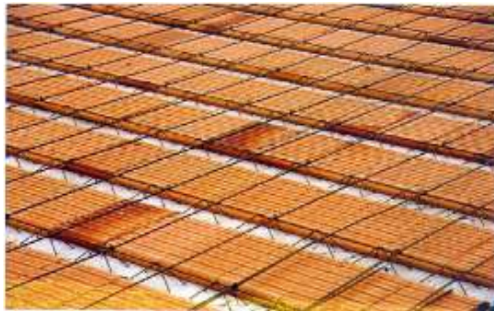
Figura 11 - Laje nervurada: treliçada Fonte: Faulim (2004).
