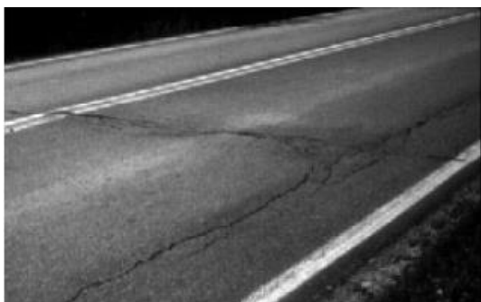
Figura 10: Trincas transversais por reflexão Fonte: Fernandes Jr et al. (2011)
