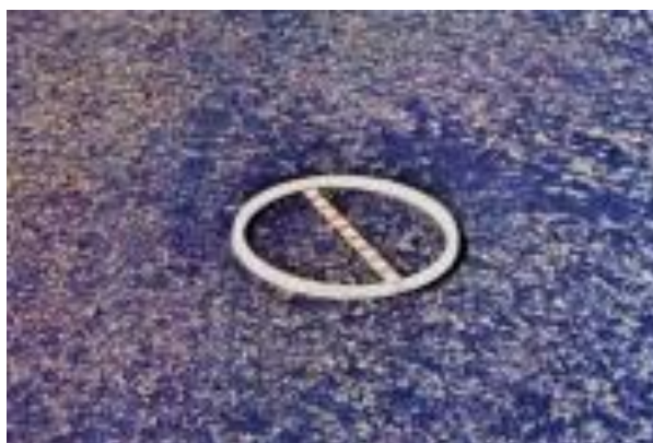
Figura 16: Esxudação Fonte: DNIT (2003)
