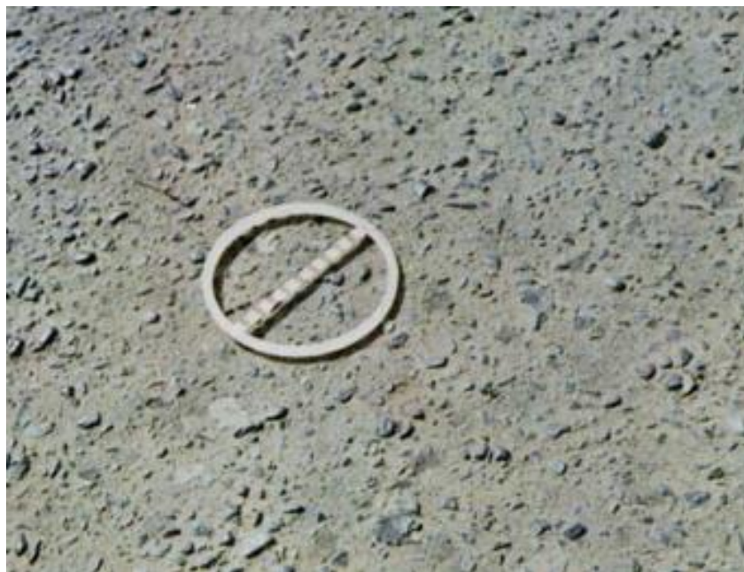
Figura 17: Desgaste Fonte: DNIT (2003)
