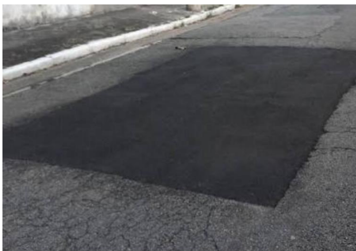
Figura 19: Remendo em pavimento flexível Fonte: Cava (2018)
