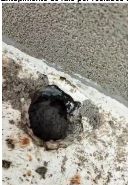
Fotografia 9 - Entupimento de ralo por resíduos sólidos.
