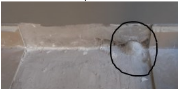
Fotografia 1- Incompatibilização entre os sistemas de drenagem de água pluvial, estrutural/fundações e revestimento.
