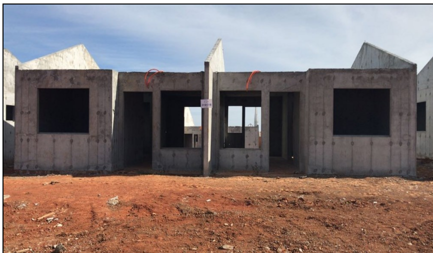
Figura 13 - Parede de concreto
