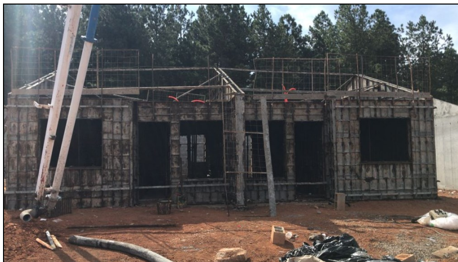
Figura 11 - Formas montadas prontas para receber a concretagem.
