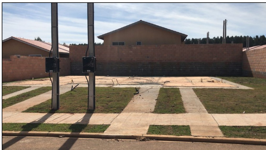
Figura 7- Fundação Radier já com a hidráulica embutida
