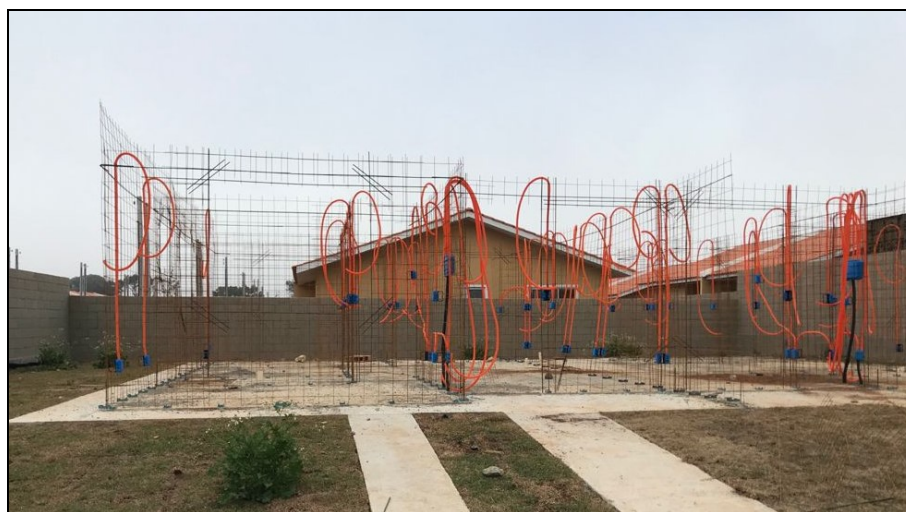
Figura 10 - Instalação elétrica embutida antes da concretagem
