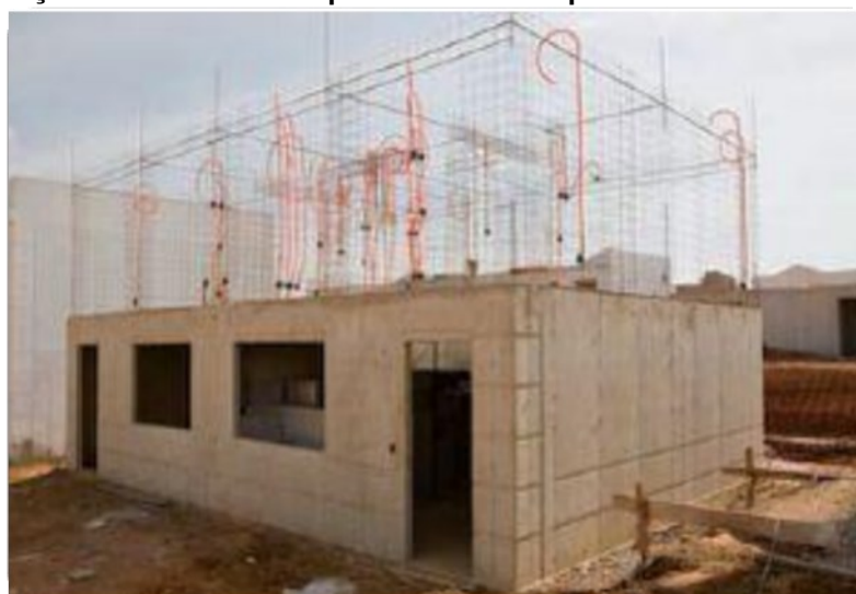
Figura 6 - Edificação confeccionada a partir do método parede de concreto moldada no local
