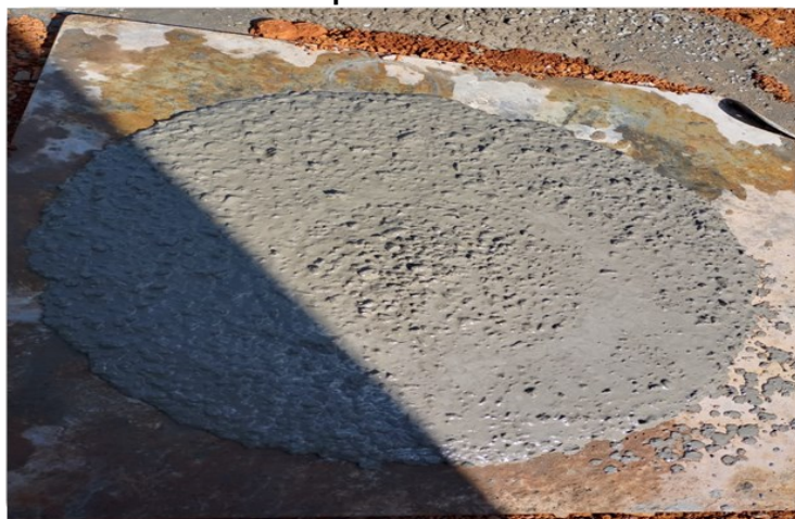
Fotografia 9 - Concreto utilizado para a estrutura das unidades habitacionais
