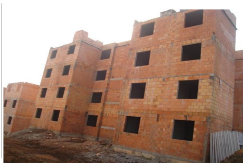
Figura 7 - Alvenaria estrutural executada em blocos cerâmicos
