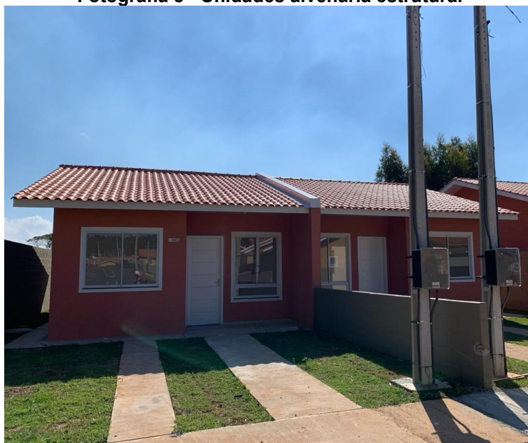
Fotografia 8 - Unidades alvenaria estrutural
