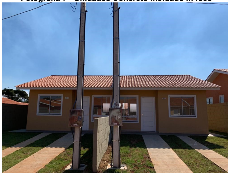
Fotografia 7 - Unidades Concreto moldado in loco
