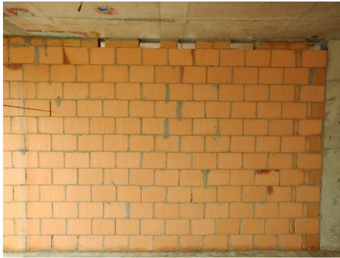
Figura 1 - Alvenaria de blocos cerâmicos.
