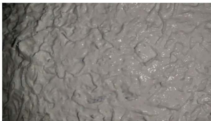
Imagem 4 - Massa acrílica texturizada antes da aplicação.
