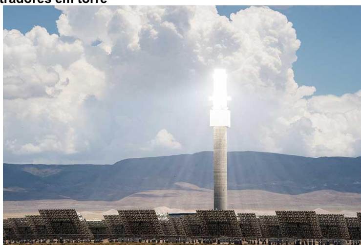
Figura 8 - Concentradores em torre
