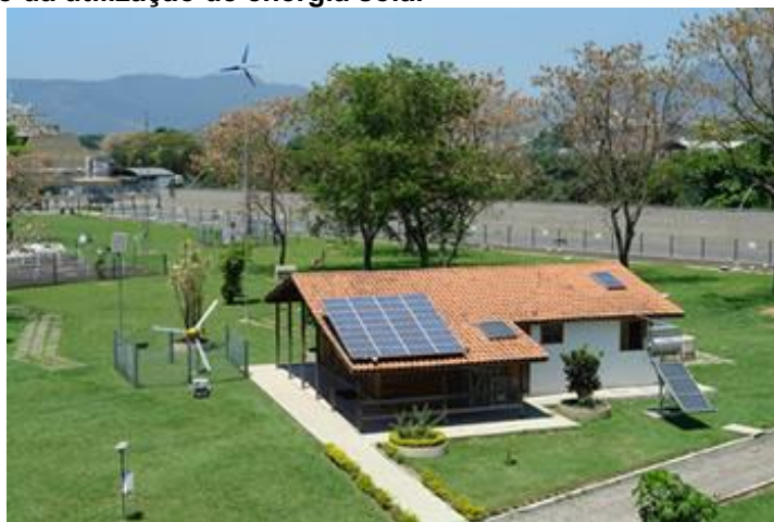
Figura 5 - Aplicação da utilização de energia solar
