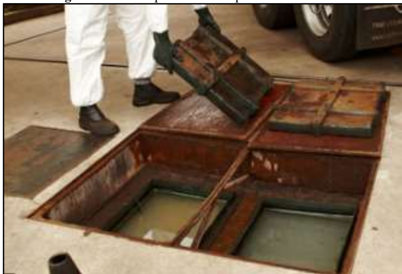
Figura 34 – Exemplo de caixa separadora de um PRC
