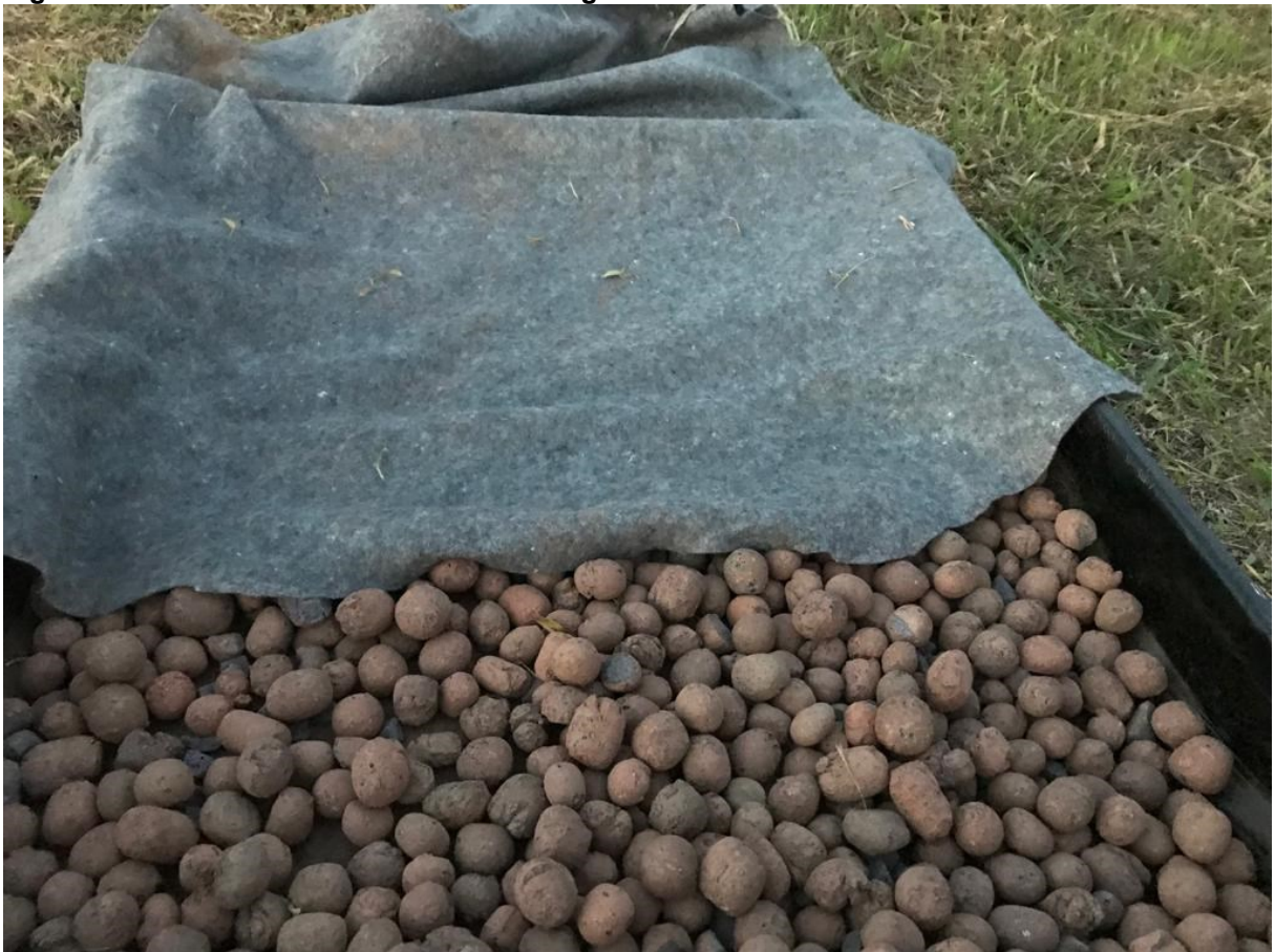
Figura 12 – Posicionamento da tela de filtragem
