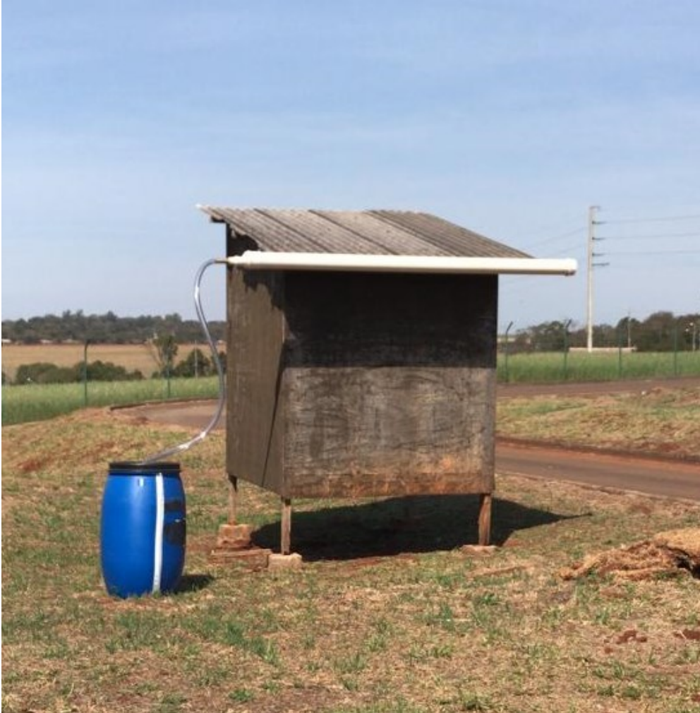
Figura 15 – Sistema de coleta de água do telhado de convencional
