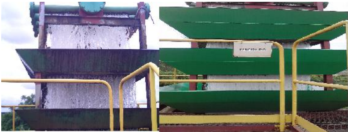
Fotografia 1. Peneira de recepção da água do rio Tibagi antes e depois do aumento das peneiras. Fonte: Heineken.
