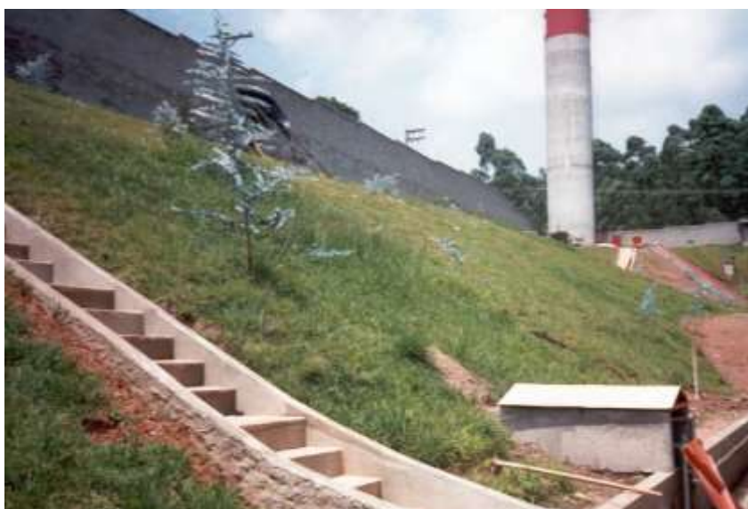
Figura 8 - Dissipador de energia do tipo escada hidráulica.
