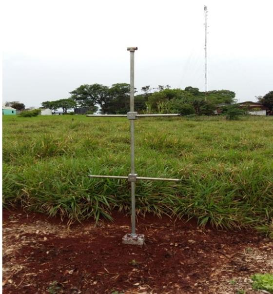
**Figura 20 – Início da montagem da estrutura metálica da estação meteorológica.**
