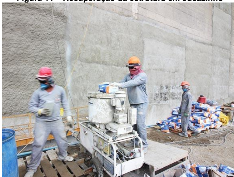
Figura 11 – Recuperação da estrutura em Jucazinho
