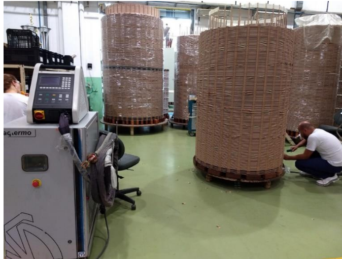
Figura 15: Área de solda, onde serão colocados os anéis de desvio de óleo. Fonte: O autor (2020).
