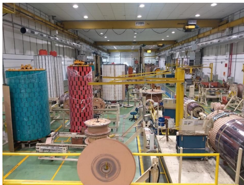
Figura 4: Foto da seção de Bobinagem de Força Fonte: O autor (2020).
