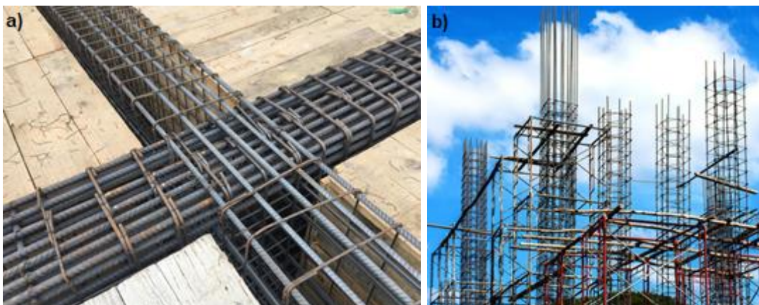
Figura 14 - Detalhes das armaduras de a) vigas e b) pilares
