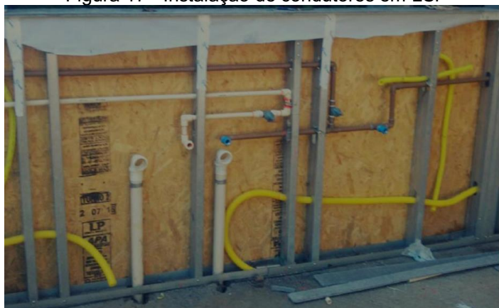
Figura 17 - Instalação de condutores em LSF
