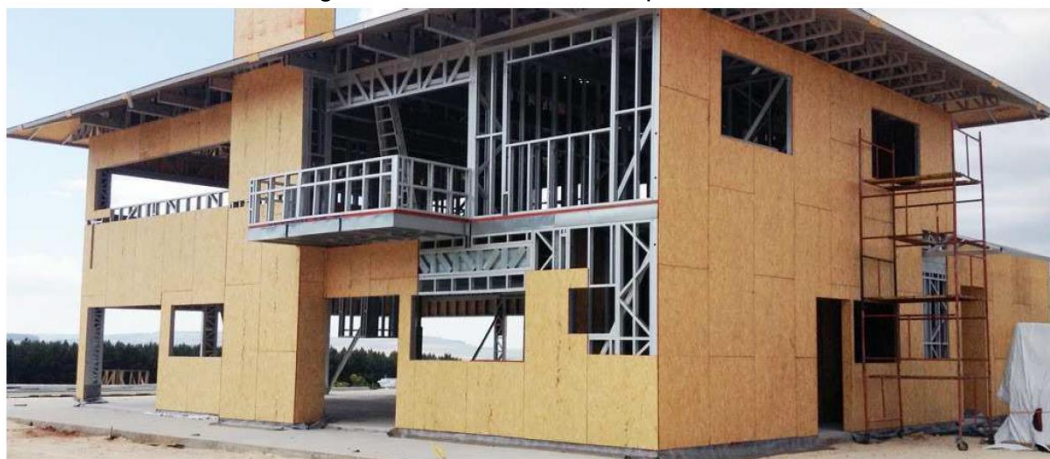
Figura 11 - Fechamento com placas OSB
