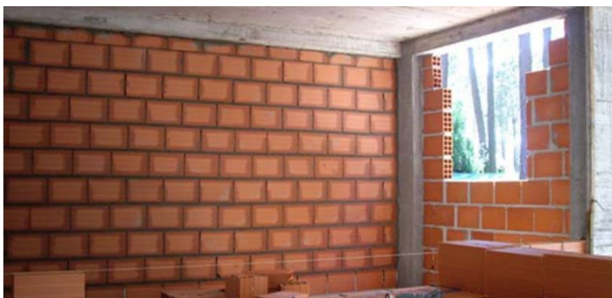
Figura 15 - Sistemas de vedação com blocos cerâmicos
