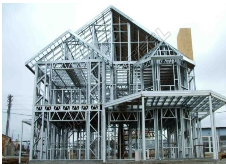
Figura 2 - Sistema construtivo Light Steel Frame
