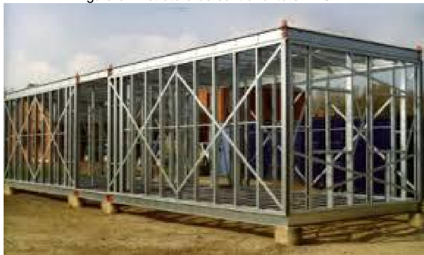
Figura 9 - Estrutura de contravento em LSF
